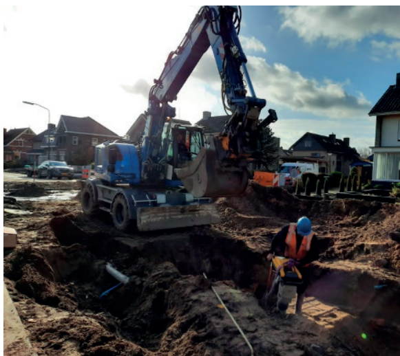
Afbeeldingen: werkzaamheden fase 1 aanleg hemelwaterriool en nieuwe bestrating
