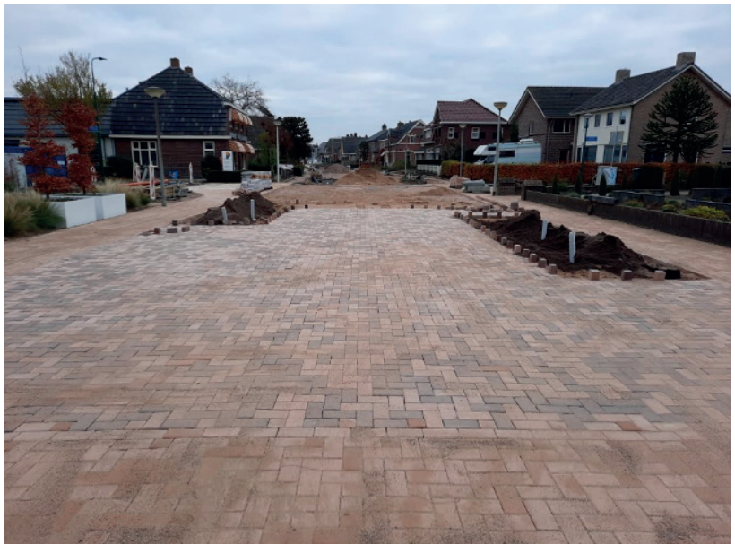
Afbeeldingen: werkzaamheden fase 1 aanleg hemelwaterriool en nieuwe bestrating
