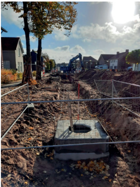
Afbeeldingen: werkzaamheden fase 1 aanleg hemelwaterriool en nieuwe bestrating
