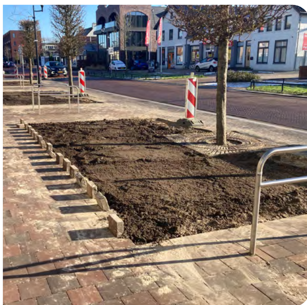
Afkoppelen regenwater door verwijderen bestrating en vergroening (Centrum Heesch)
