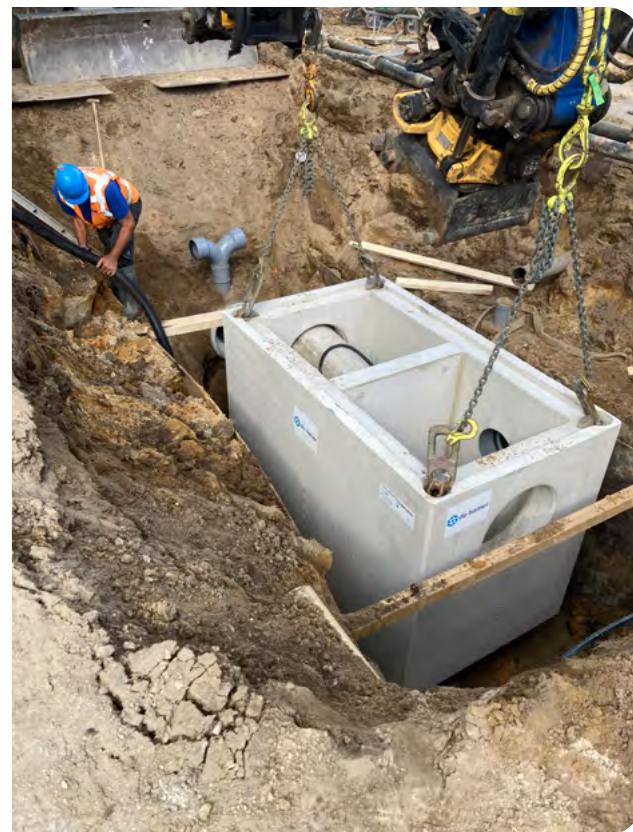
Aanleg rioolput Heeswijkse Akkers Heeswijk-Dinther
