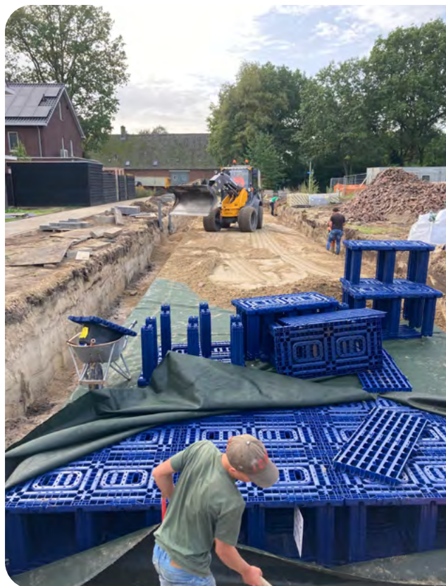
Aanleg infiltratiekragen, De Erven Heesch
